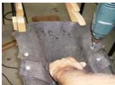
Fig. 8 – Fixação das Telhas.
