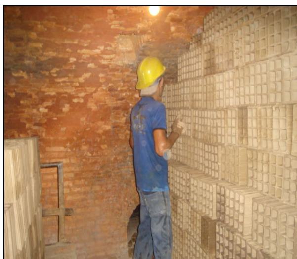
Figura 3 - Operário dentro da área do forno intermitente - Calor
